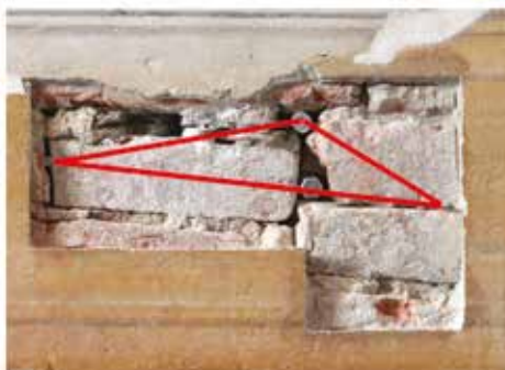
3. Schema della geometria triangolare per la disposizione degli ancoraggi
