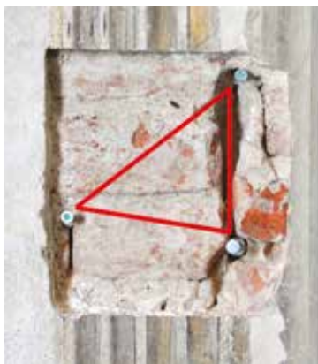
3. Schema della geometria triangolare per la disposizione degli ancoraggi
