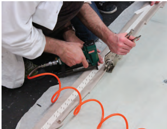
9. Fasi di ancoraggio dello strep lining sul retro del nuovo pannello
