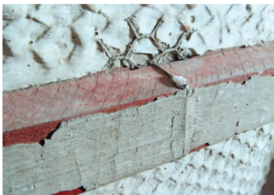
5. Paolo Uccello, Il Diluvio universale e la recessione delle acque : particolare delle legature tra il telaio ligneo e la rete metallica
