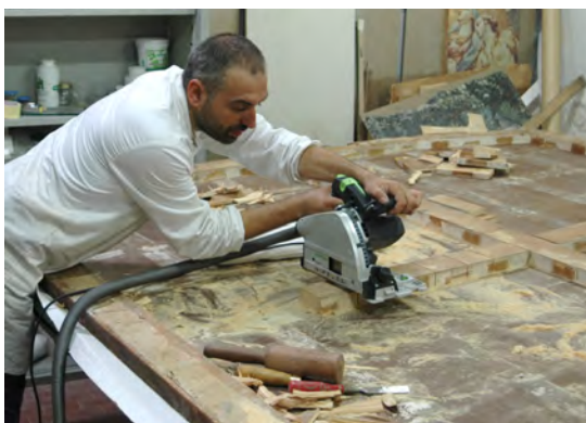
2. La rimozione delle strutture di sostegno dei supporti di Tintori
