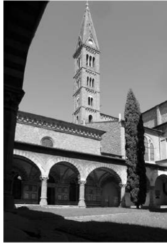
Figura 1. Veduta del lato nord del chiostro
