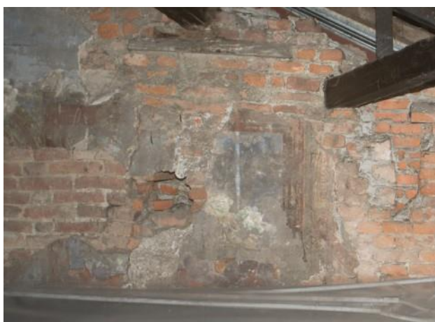
9. Particolare della parete sud-est prima dell'intervento
