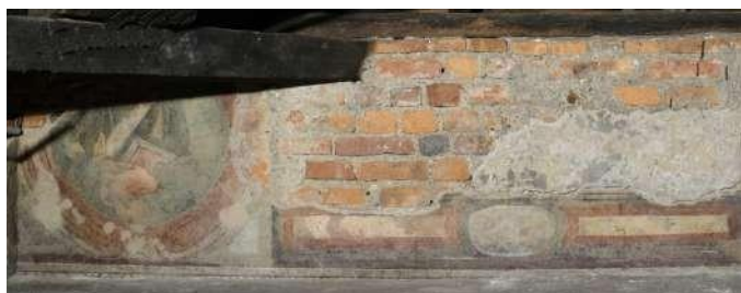
1. Particolare parete sud-ovest dopo il restauro
