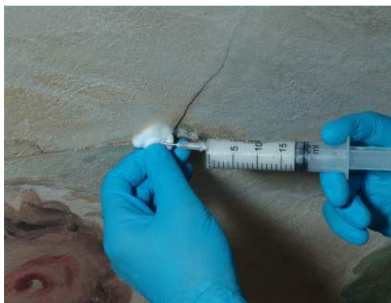
Fig. 5 Infiltrazioni di malta idraulica PLM-A ®.
