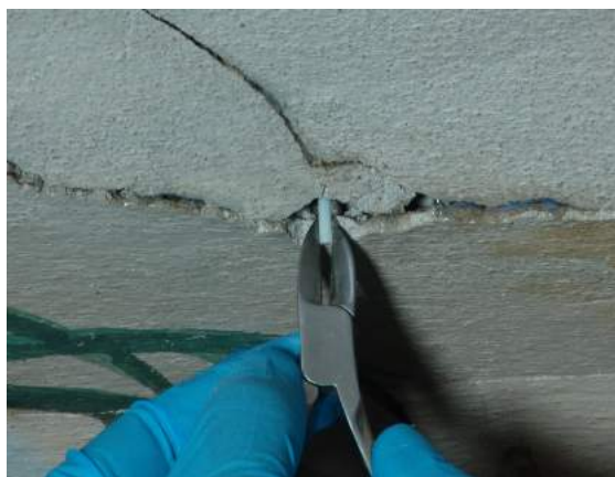
Fig. 4 Inserimento di perni in vetroresina.
