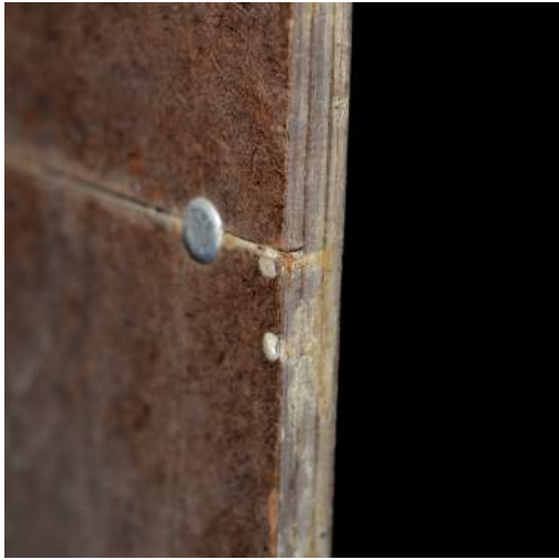
Fig. 2 Particolare del triplice strato di masonite
